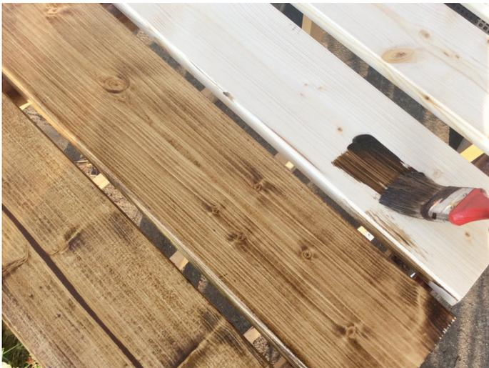
Um die einzelnen Holzbretter gleichmäßig von jeder Seite zu lasieren, bietet es sich an, diese auf Holzböcke zu legen. Bevor die Teile zusammengeschaubt werden, sollte die Lasur zuerst vollständig trocknen.
